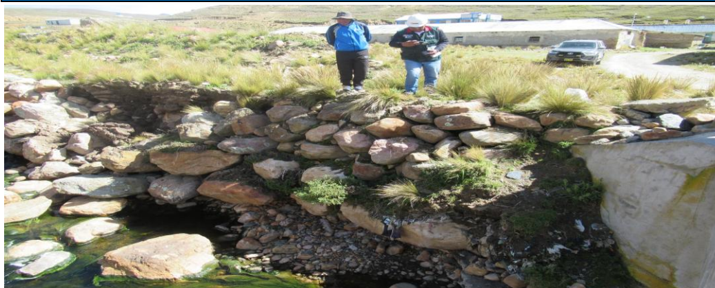
FIGURA N°01: TRAMO CRÍTICO I EN ILA QUEBRADA LAHUALAHUANI ZONAS VULNERABLES A LA SOCAVACION DE LA RIBERA DEL QDA EN LA MARGEN IZQUIERDA, AFECTANDO EL MURO PIEDRAS QUE PROTEJE AL CENTRO POBLADO TRAPICHE.
