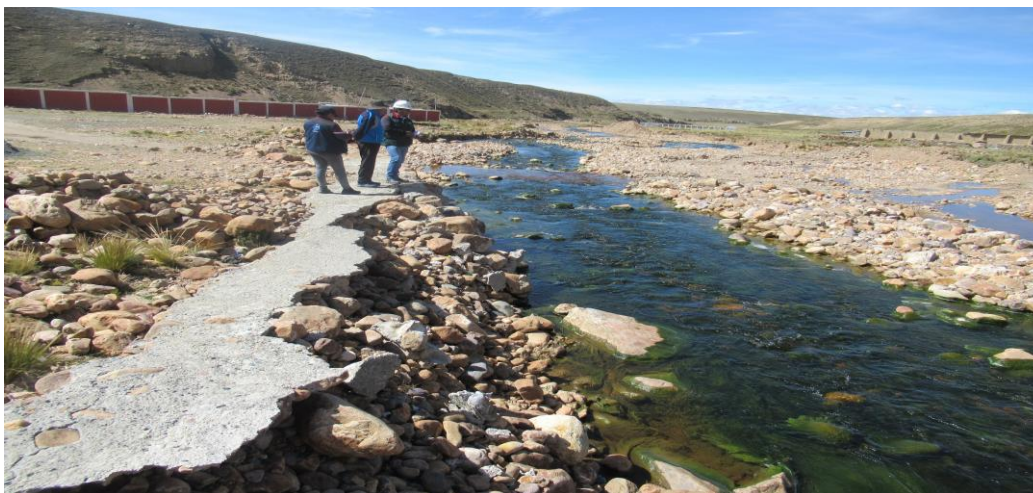
FIGURA N°02: TRAMO CRÍTICO I EN ILA QUEBRADA LAHUALAHUANI ZONAS VULNERABLES A LA SOCAVACION DE LA RIBERA DE LA QDA EN LA MARGEN IZQUIERDA, AFECTANDO EL MURO PIEDRAS QUE PROTEJE AL CENTRO POBLADO TRAPICHE.
