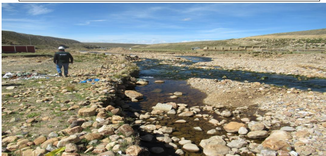
FIGURA N°03: TRAMO CRÍTICO I EN ILA QUEBRADA LAHUALAHUANI ZONAS VULNERABLES A LA SOCAVACION DE LA RIBERA DEL QDA EN LA MARGEN IZQUIERDA, AFECTANDO Y DERRUMBANDO EL MURO PIEDRAS QUE PROTEGIA AL CENTRO POBLADO TRAPICHE.
